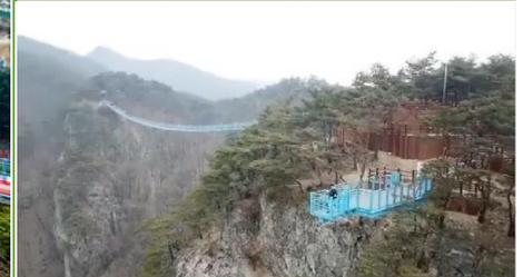
2018年1月開原州小金山懸索吊橋，是原州市地正面良峴景點內小金山登山路之其中一段，建築在100m高的岩壁上，連接山峰的大橋長200m寬1.5m，是國內山嶽散步路中最大及最有規模的一條橋。利用了8折直徑40mm的特殊鍍金纜繩將兩邊固定並從下支撐，設計確保約1,285名體重70kg的成人能同時通過這條大橋，並能抵禦在秒速40m的強風。旁邊還設有讓你嚇到腳軟觀景臺，高空景色，優美壯麗。
